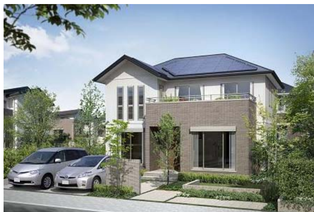
複雑な形状の屋根に設置した太陽光発電
