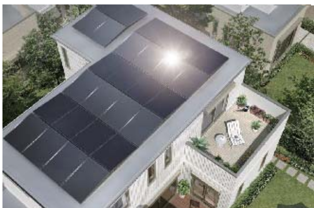
薄膜太陽電池を陸屋根に設置した住宅
