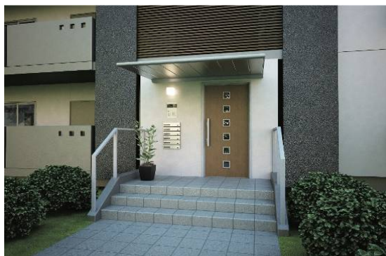
オートロック対応も可能な共用エントランス
