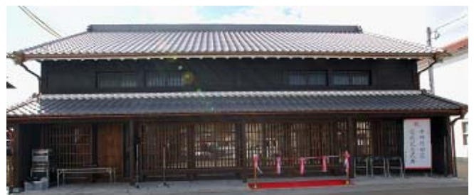
再生された町家
